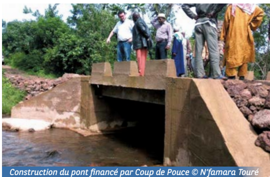
Construction du pont financé par Coup de Pouce © N'famara Touré
